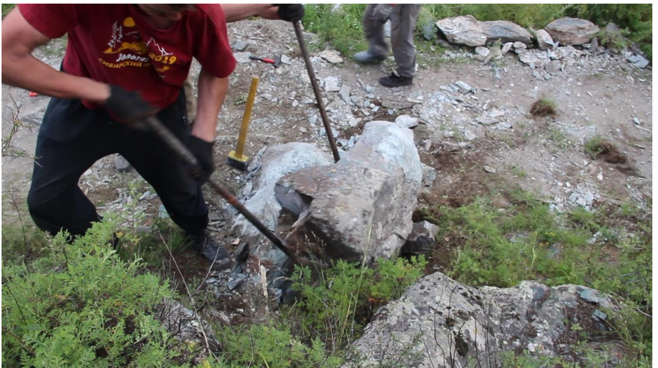
Фото 34. Отломившуюся часть камня ломами отталкиваем с тропы вниз по склону
