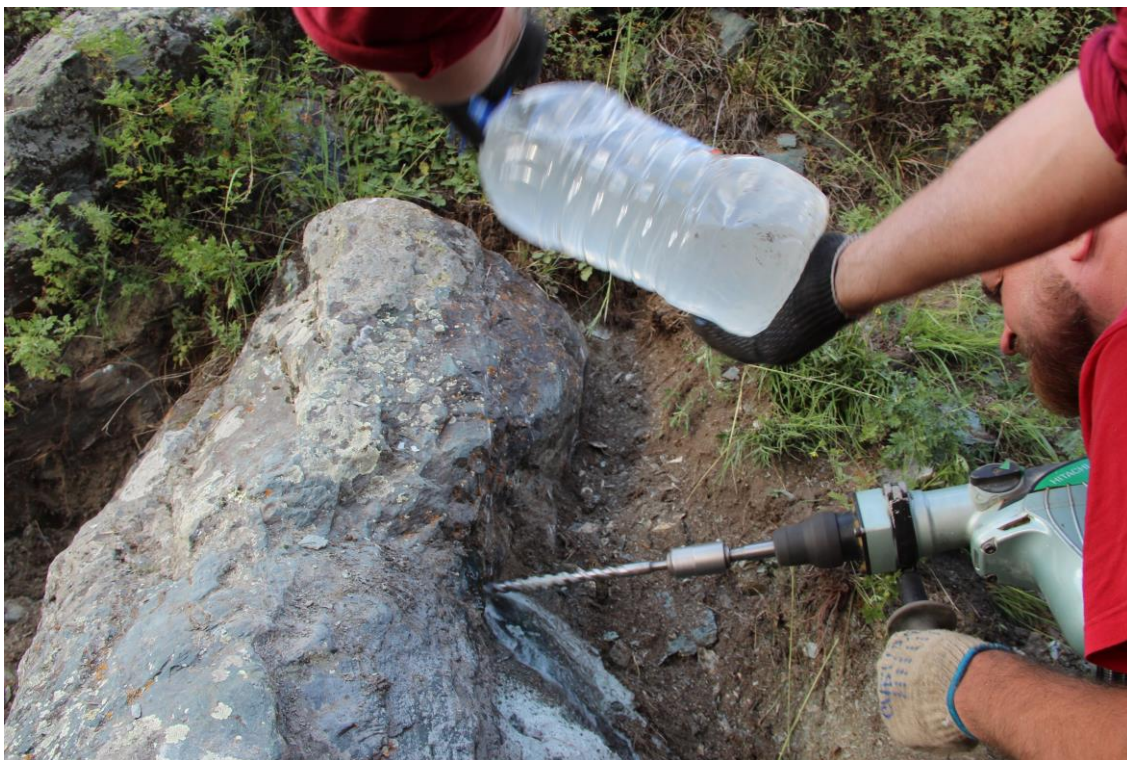
Фото 31. Удаление части большого камня с тропы, для уменьшения крена. Буром сверлим отверстия для камнекольных камней. Поливаем водой, т.к. бур греется.
