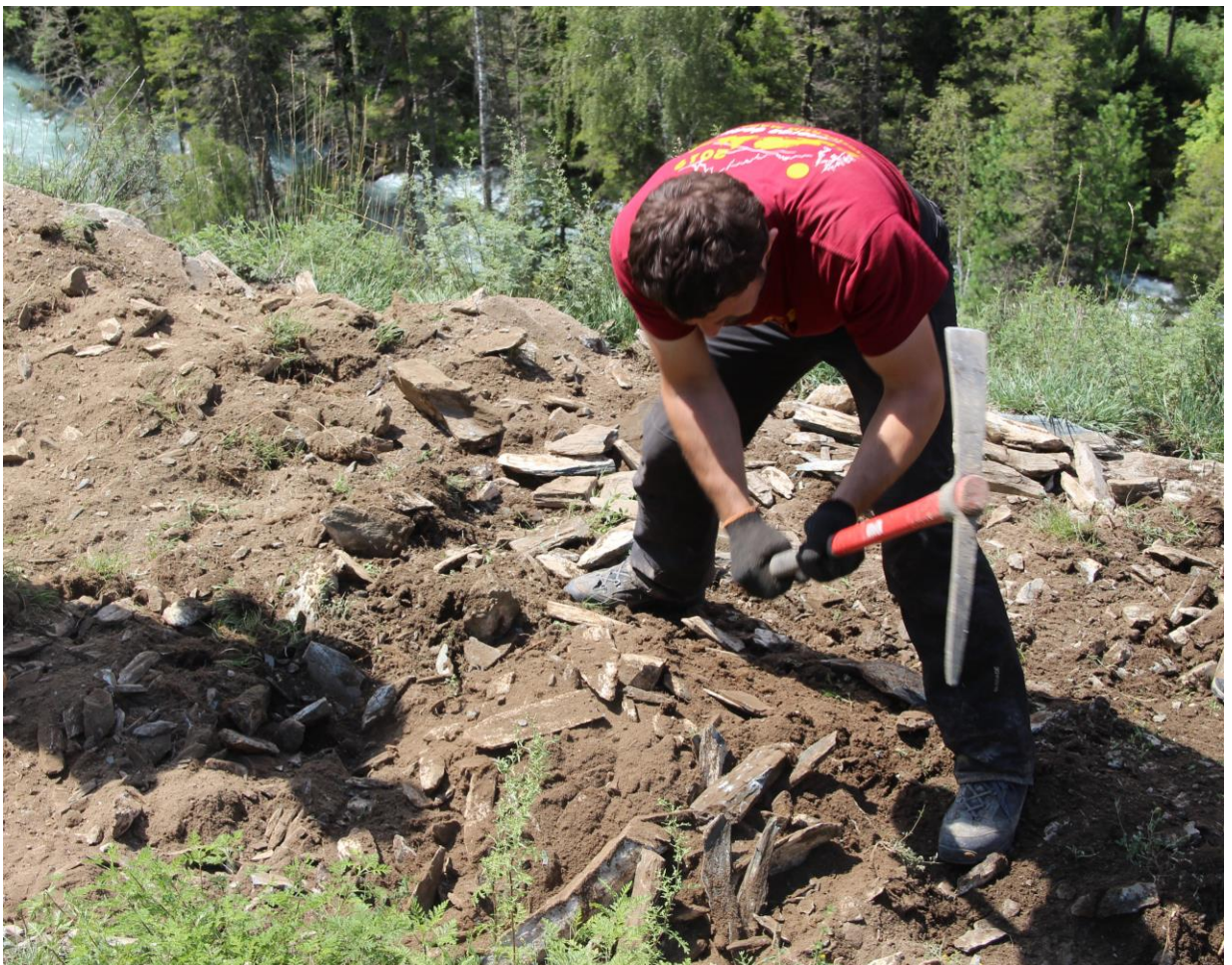
Фото 18. Выравнивание крена и расширение тропы.
