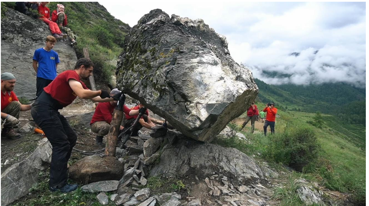
Фото 28. Камень более 10 тонн. 4 гидродомкрата в работе
