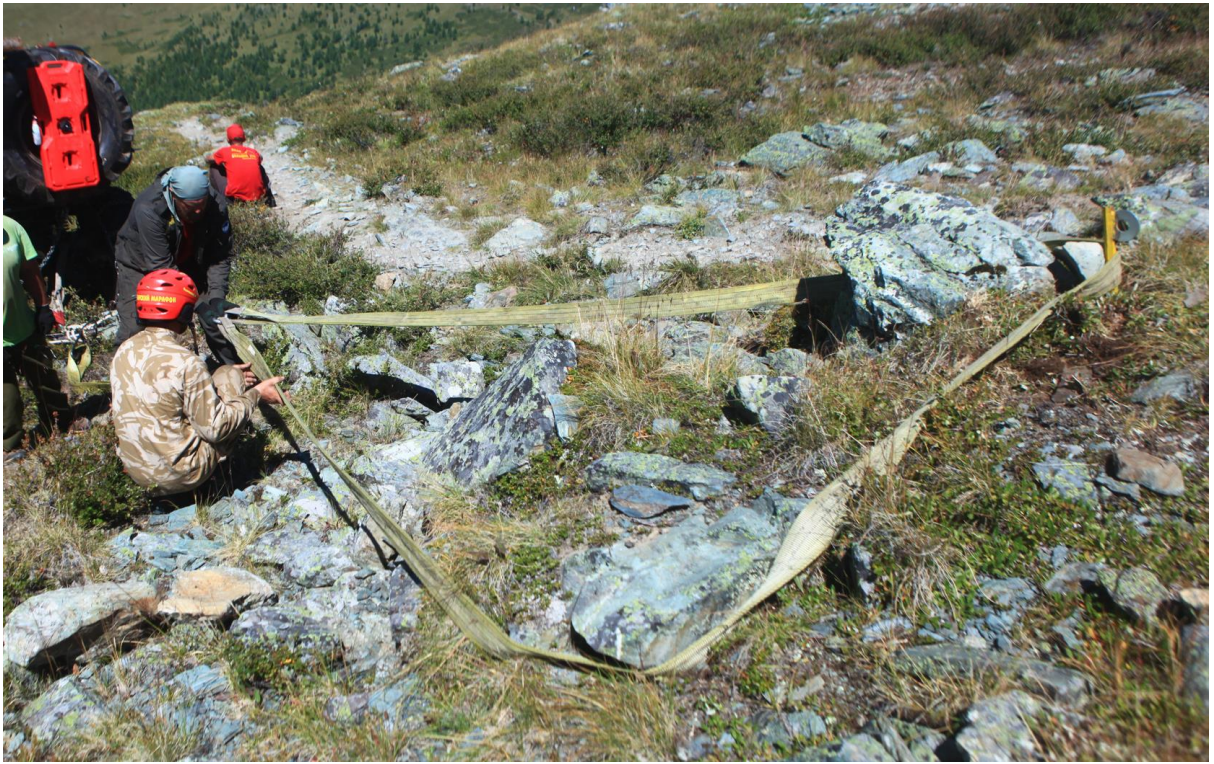
Фото 102. Траверс в долину р. Чок-Чок. Методы крепления страховки для спуска автомобилей.
