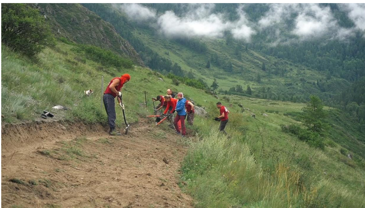
Фото 16. Выравнивание крена и расширение тропы.
