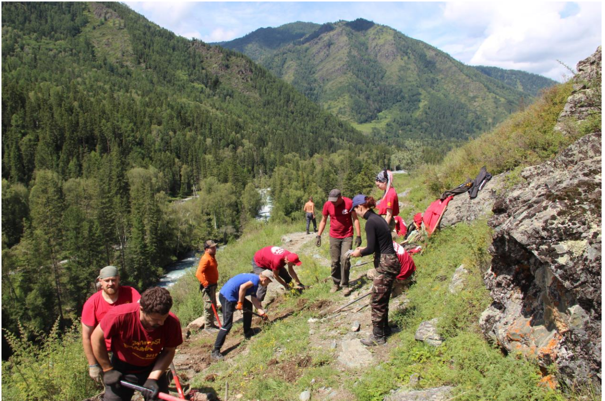
Фото 17. Выравнивание крена и расширение тропы.
