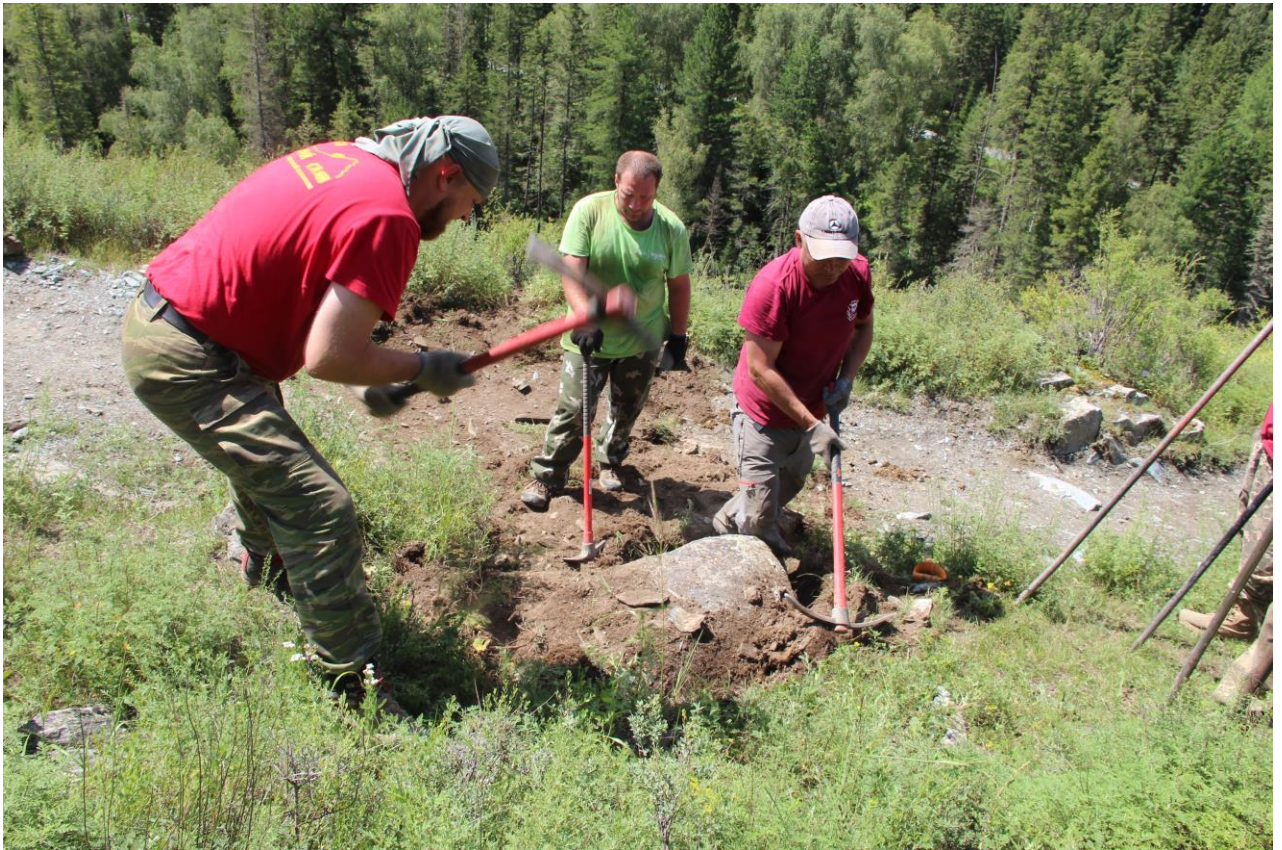
Фото 19. Убираем с тропы камни. Используется кайло.
