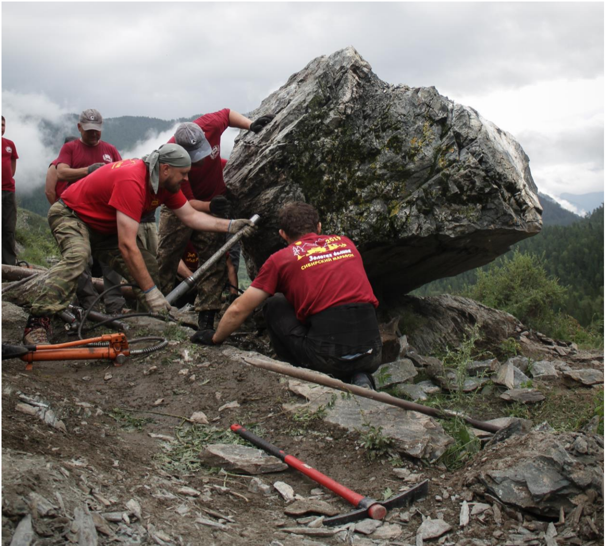
Фото 27. Дополнительный упор гидроцилиндром
