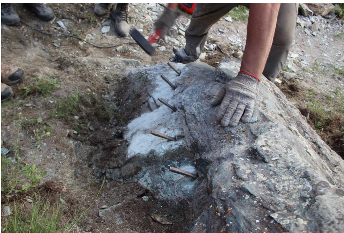
Фото 32. Удаление части большого лежащего камня с тропы для уменьшения крена. Забиваем камнекольные клинья.
