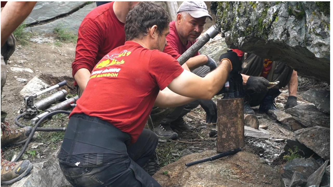
Фото 26. По мере подъёма переставляем домкраты.
